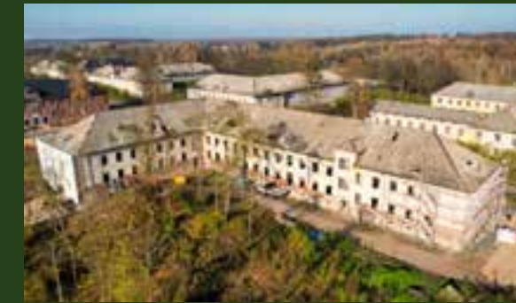
Gebäude MK09 während der Sanierung
